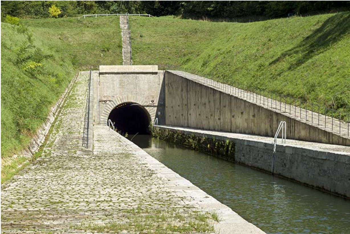
Entrée aval depuis le chemin de halage.
