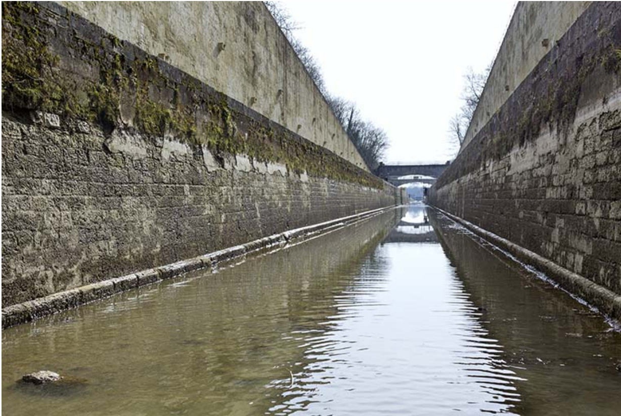
Le canal, vue prise depuis le radier.
