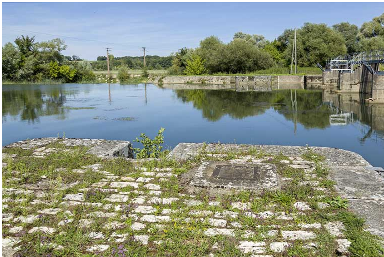
Emplacement de l'ancien barrage à aiguilles.
