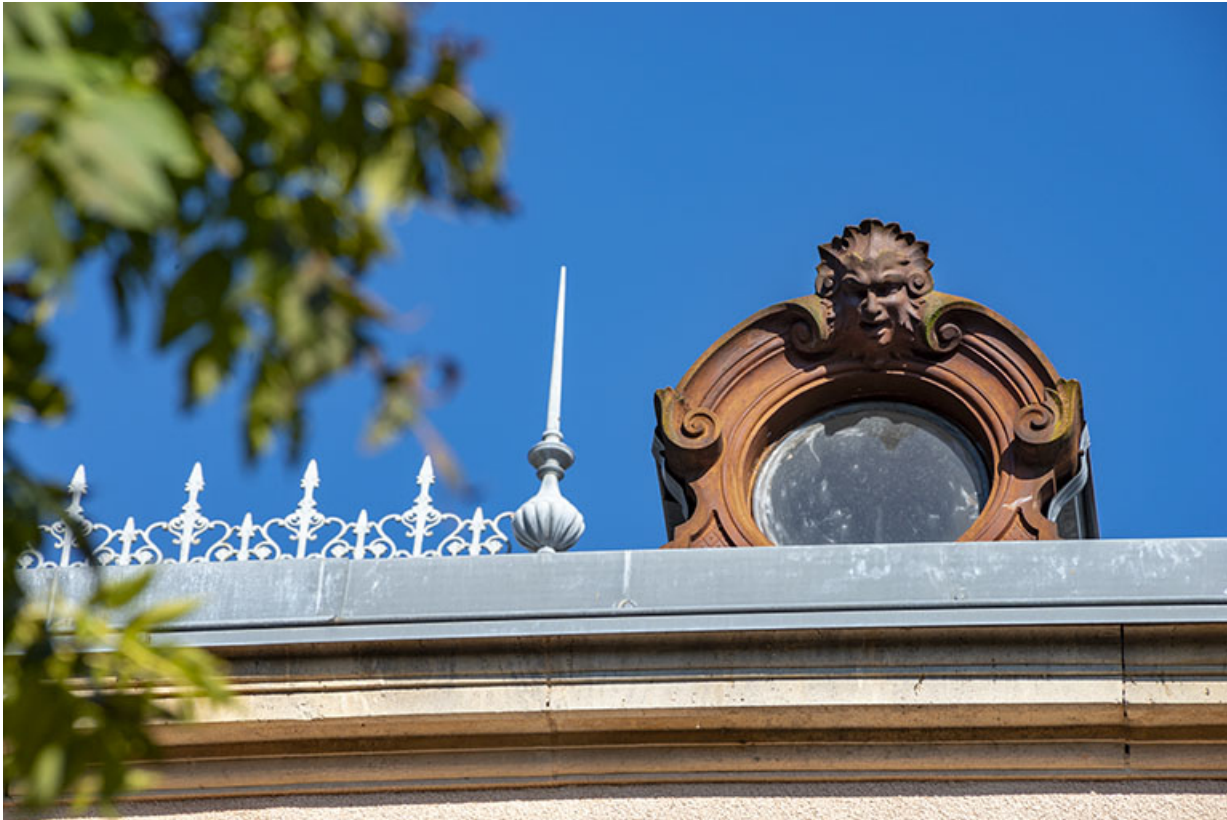
Lucarne, façade postérieure.
