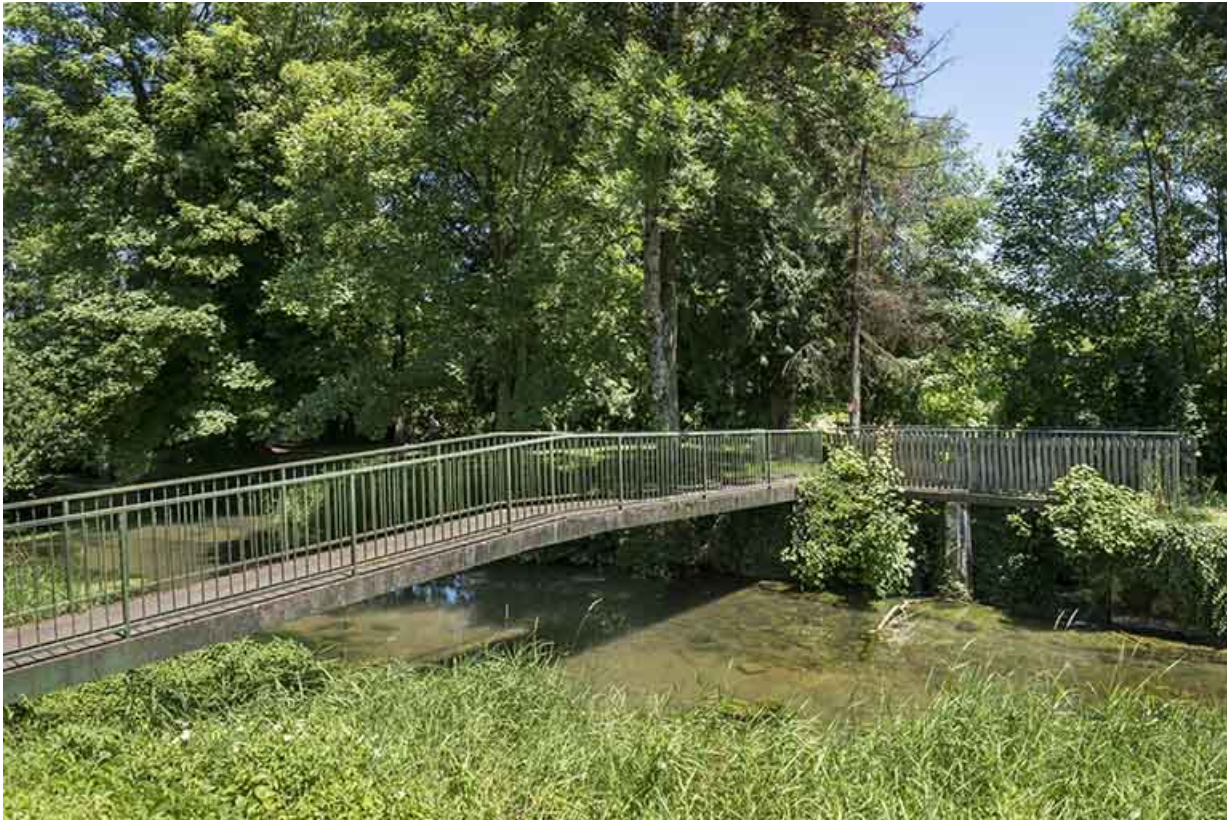
Passerelle au-dessus du ruisseau.
