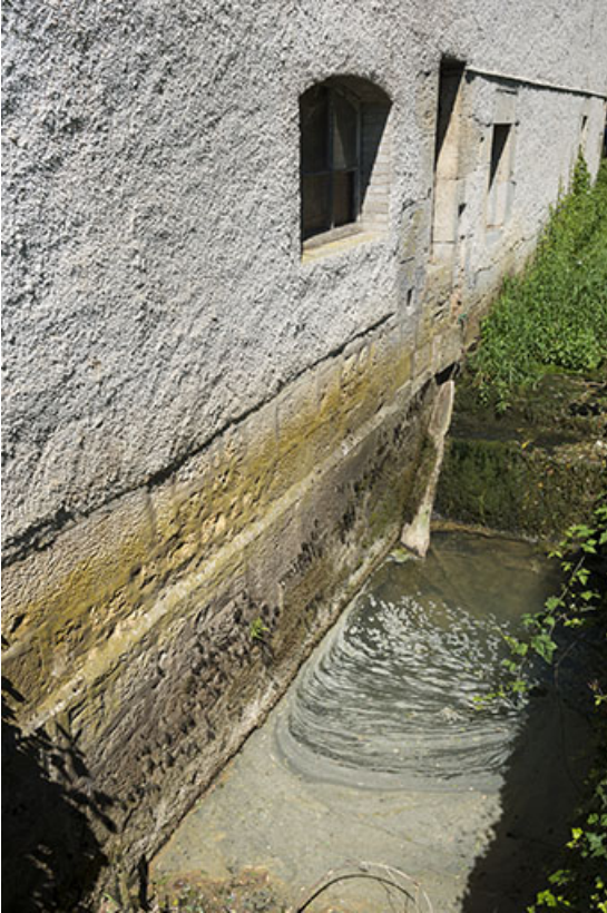
Élévation sur le ruisseau, détail.
