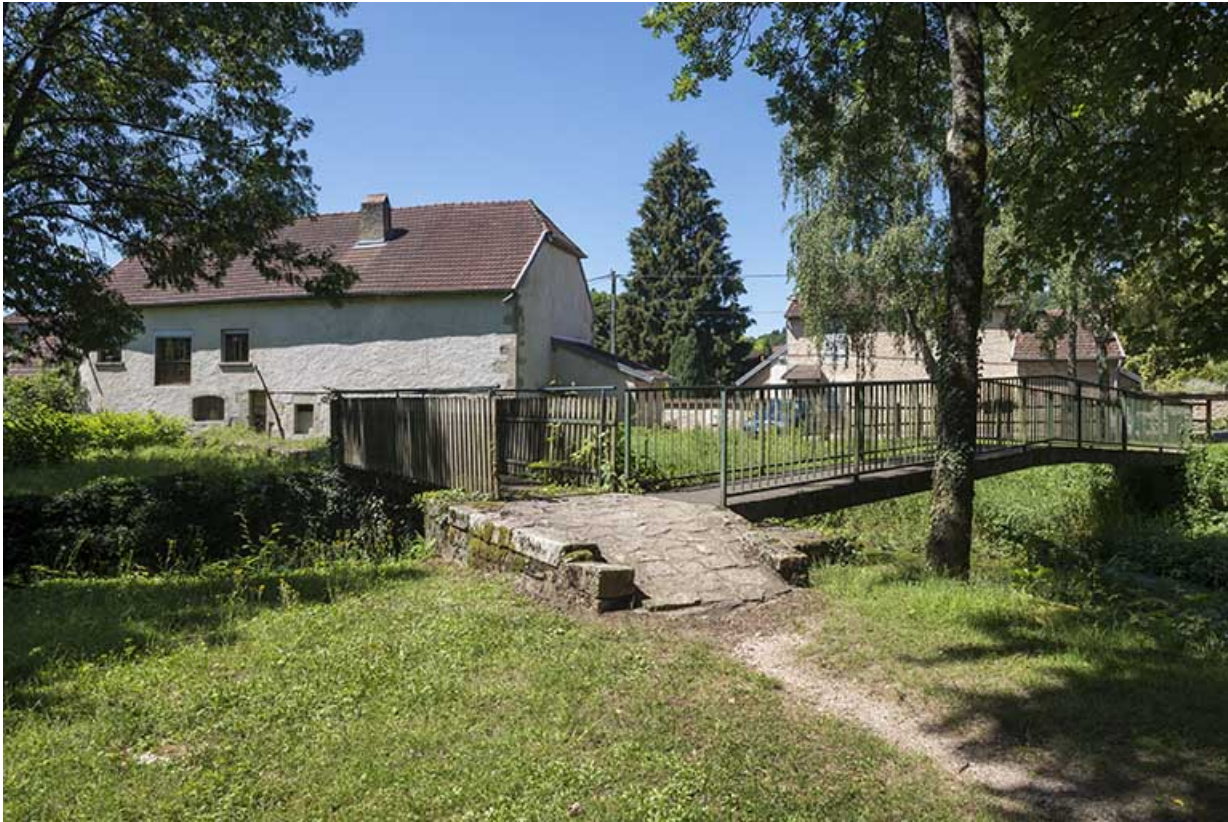
L'ancien moulin, rue du Petit Moulin.
