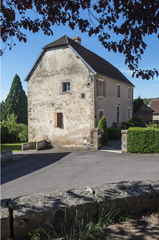
Le mur pignon nord.
