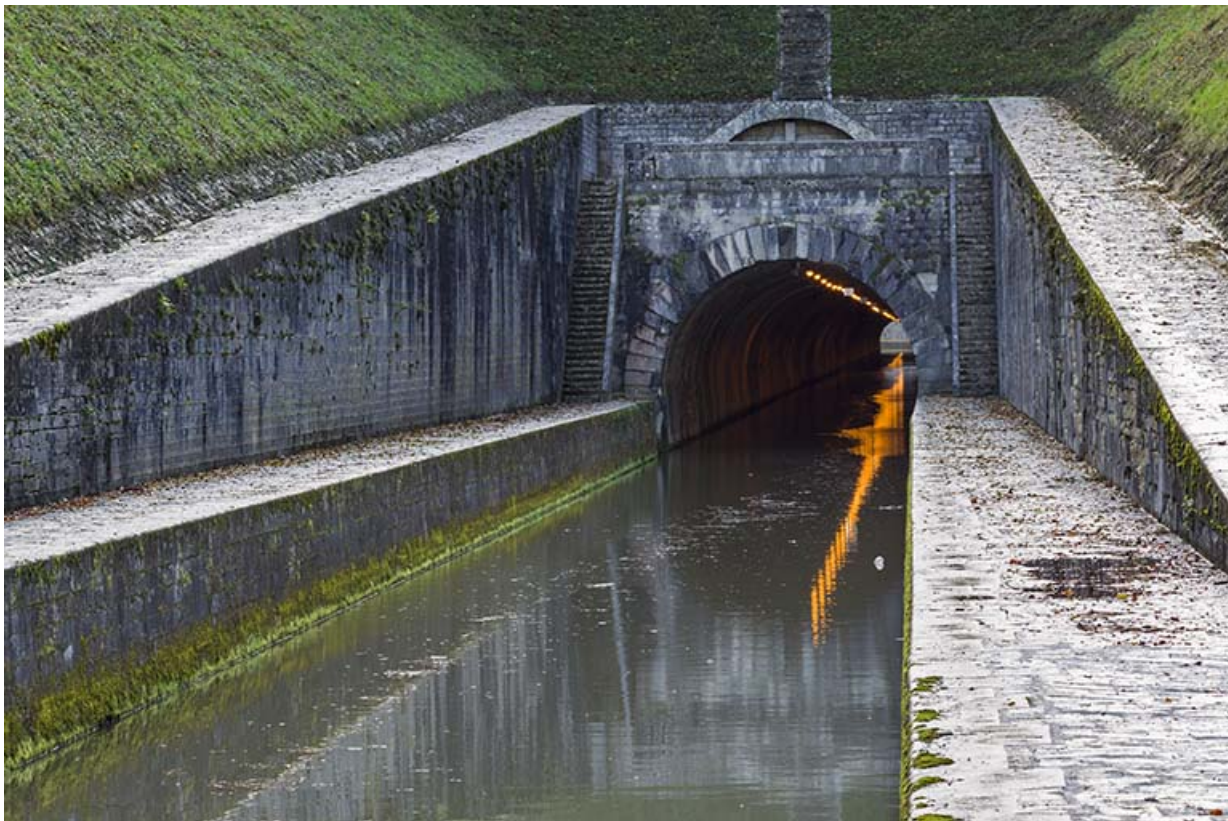
Le tunnel de Saint-Albin.
