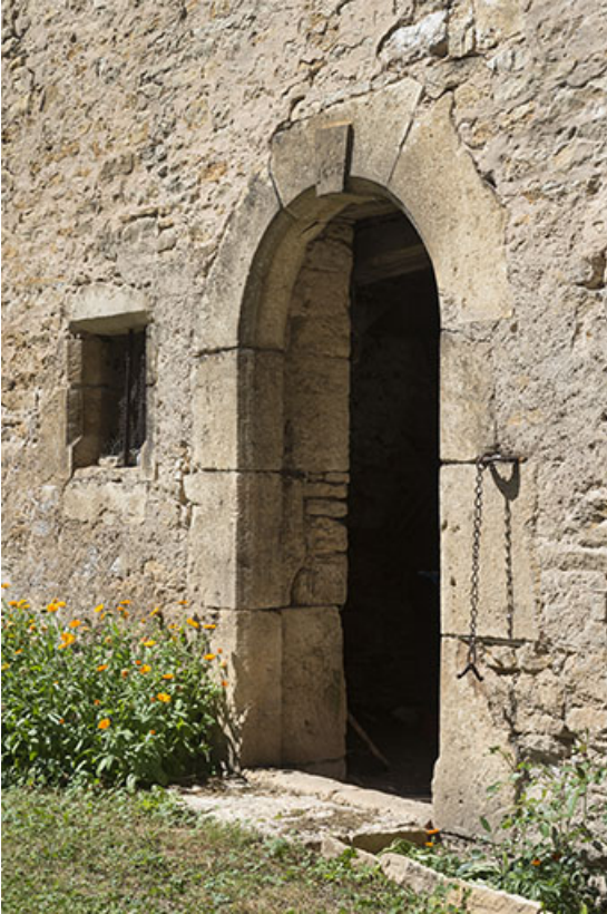
Porte de la remise.
