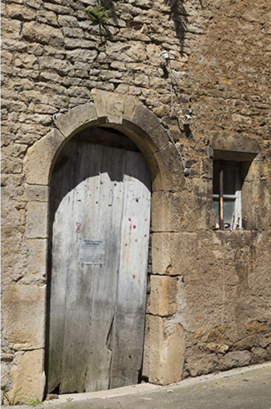
Porte de la remise.
