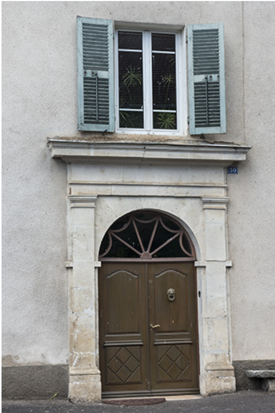
Façade antérieure : détail de la porte d'entrée.
