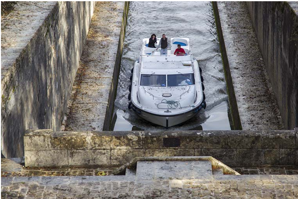
Bateau s'apprêtant à entrer dans le tunnel.
