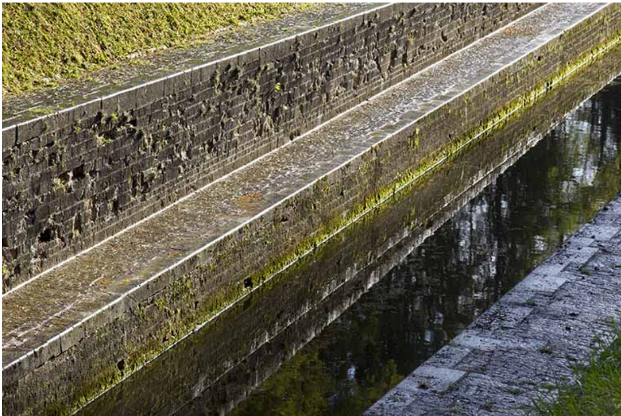
Vue sur la maçonnerie du canal.
