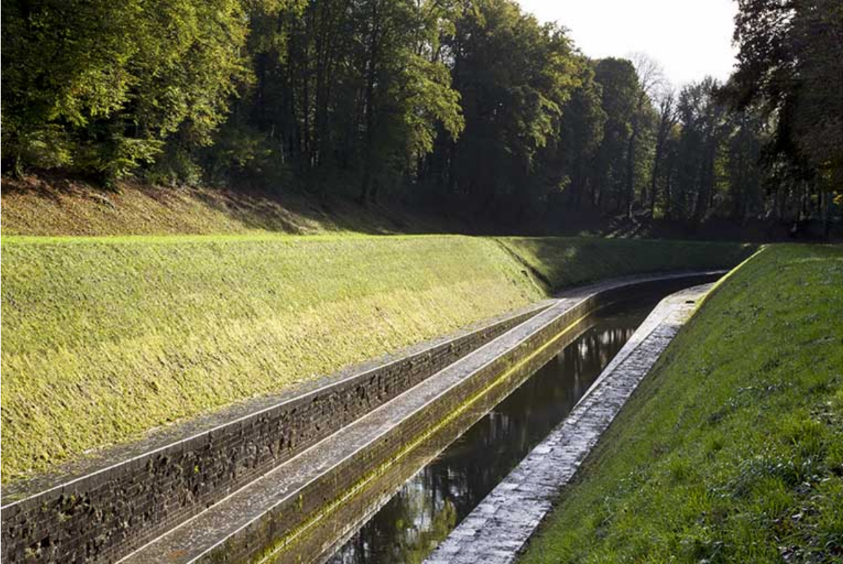
Le canal, vue aval.
