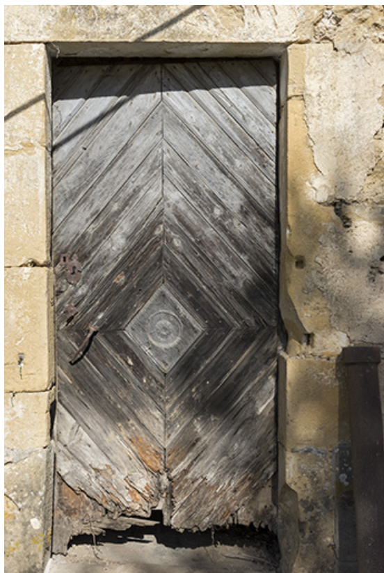
Porte piétonnière. Détail de menuiserie en losange. (bâtiment de gauche)
