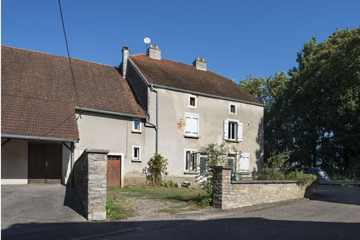
Vue depuis la rue de l'Eglise.
