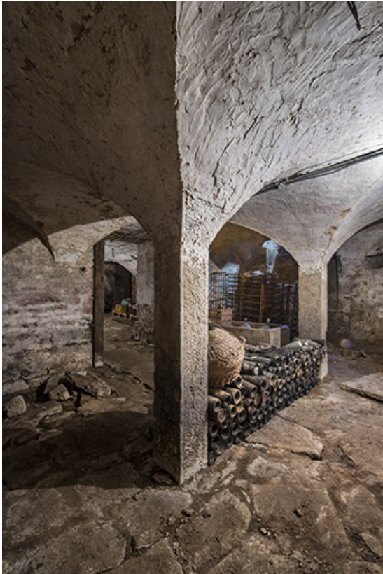
Détail d'une colonne supportant les voûtes.
