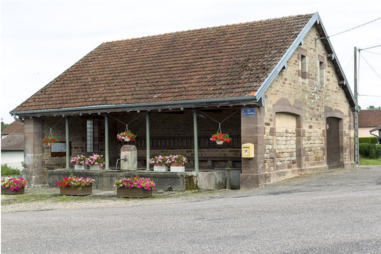
Fontaine-lavoir, rue de la Fontaine.
