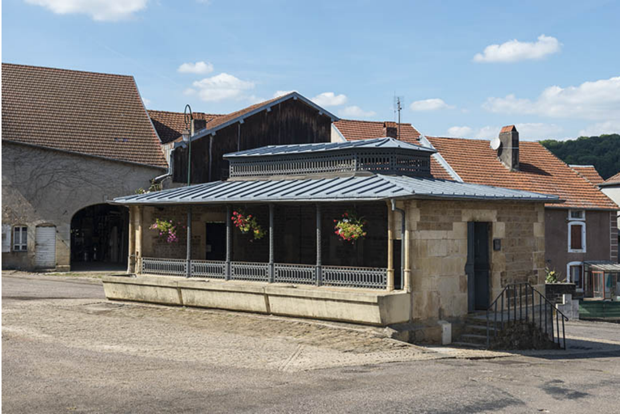
Fontaine-lavoir, rue du Vaux.
