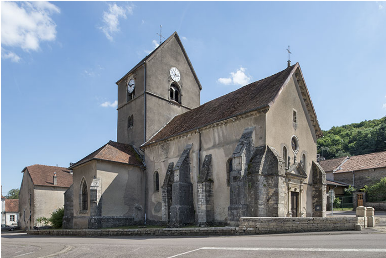
Vue avant restauration (2016).
