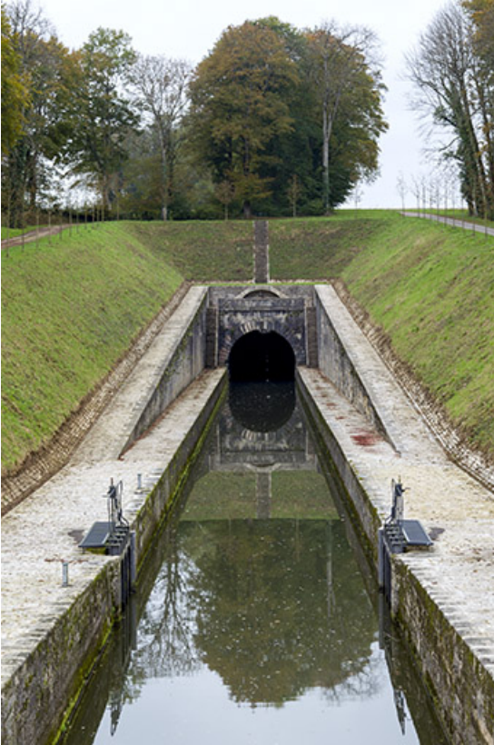
Entrée amont du tunnel de Saint-Albin.
