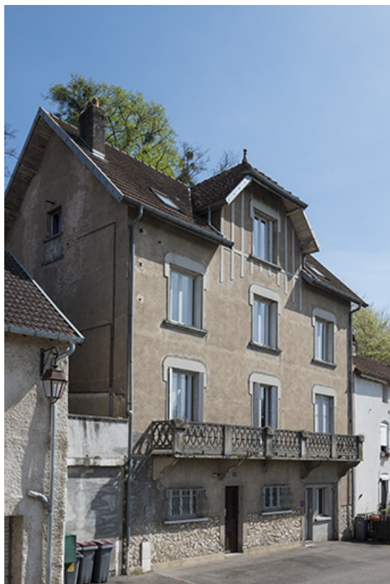
Façade principale du pavillon.
