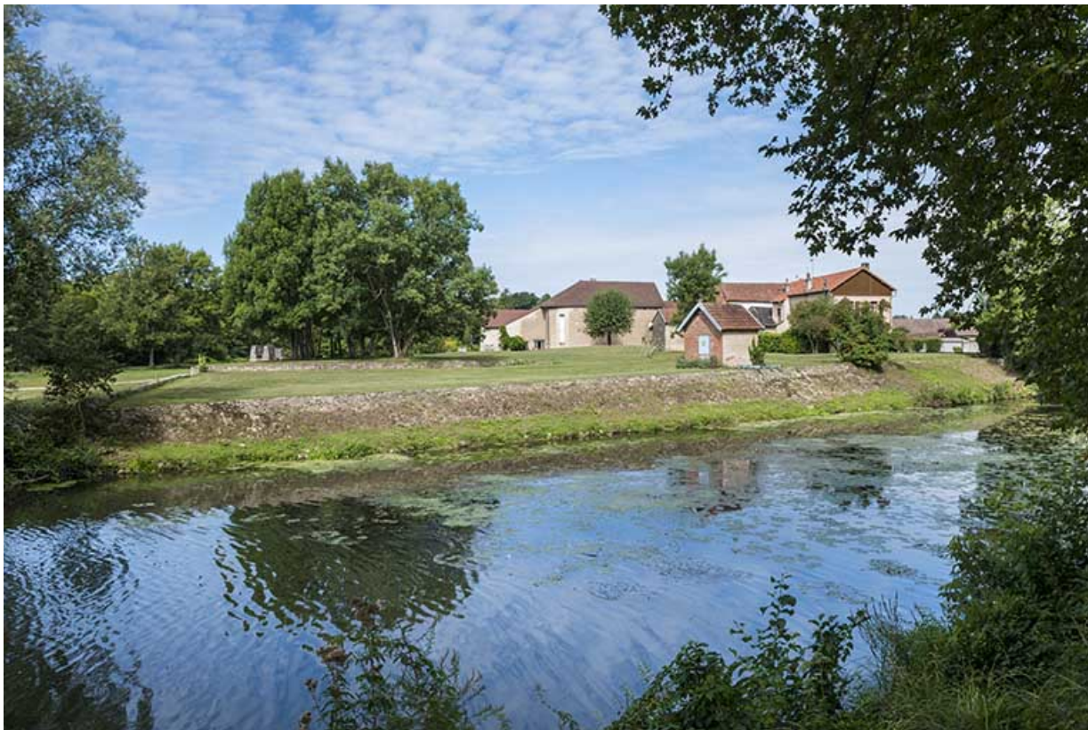
Sud de l'île, vue depuis la digue.
