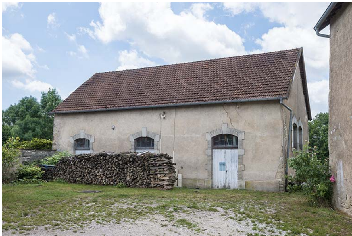
Le bâtiments servant d'abattoir.
