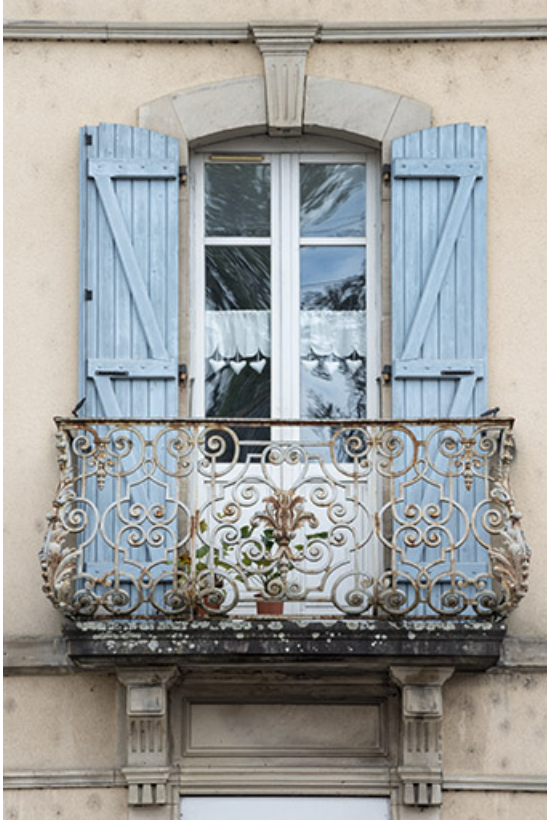
Le balcon, travée centrale.
