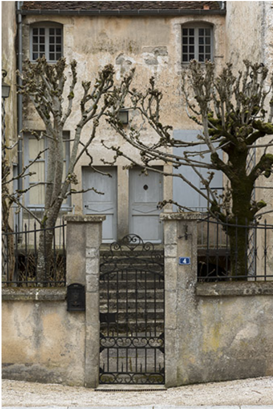
Façade antérieure : travées centrales.
