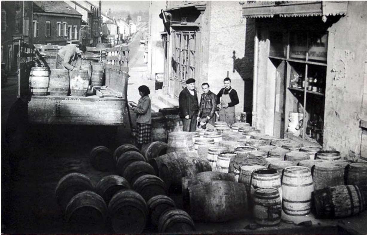
Déchargement de tonneaux dans la rue principale.
