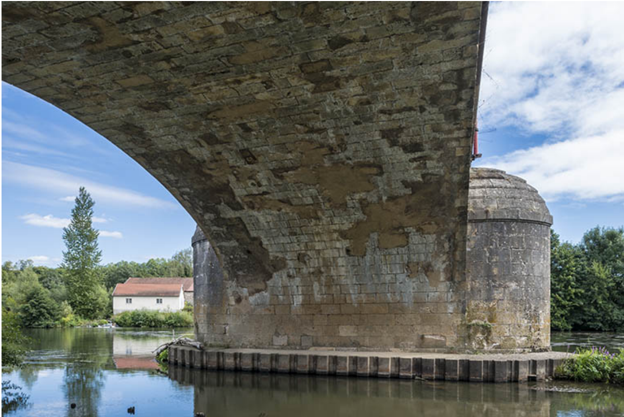
Détail sur la maçonnerie de l'édifice.
