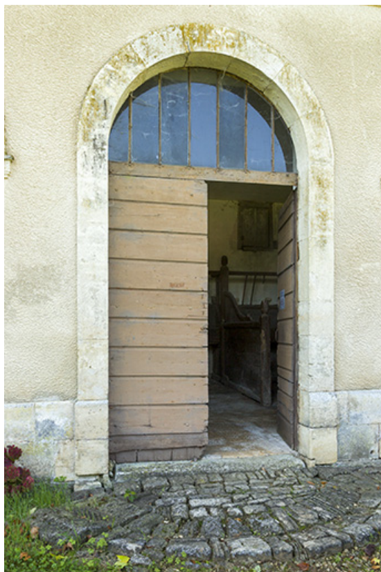
Ecurie, façade nord-est : la porte.
