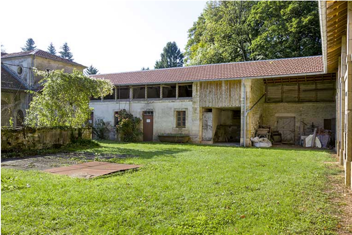
Vue générale de l'aile sud-ouest, côté cour.
