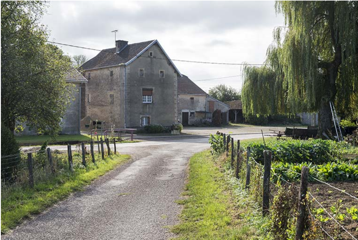
Vue depuis la rue de la Charlotte.
