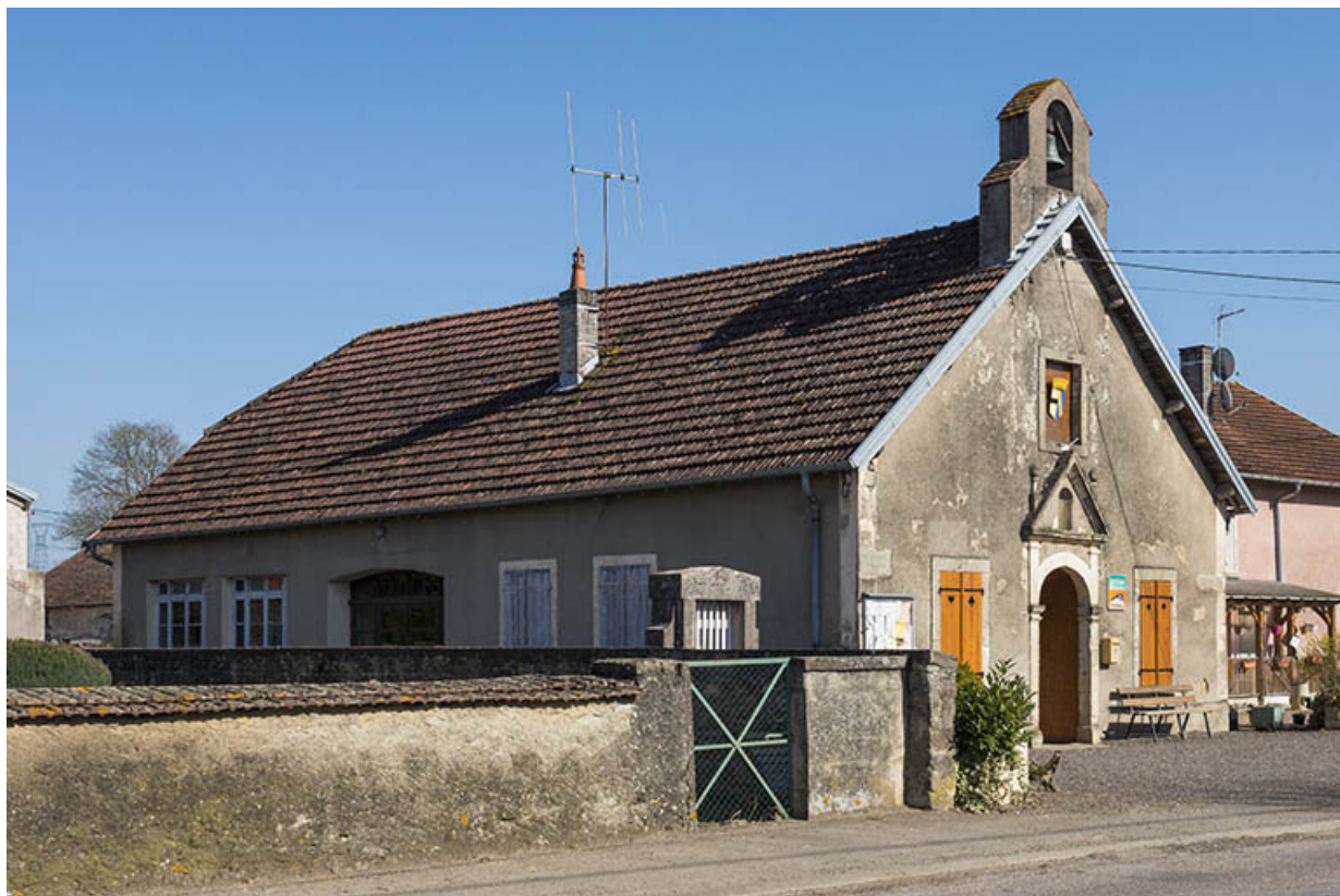
Vue latérale de l'édifice.
