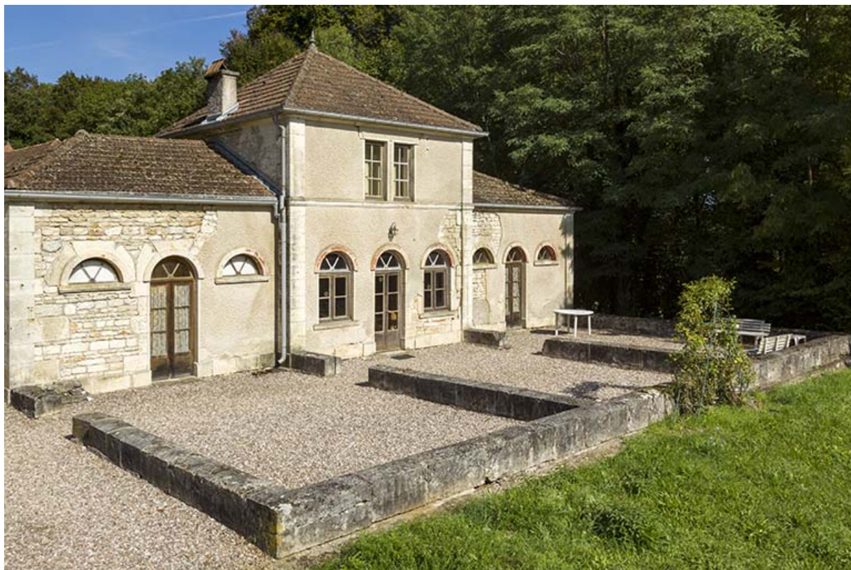
La façade antérieure, exposée au sud-est.
