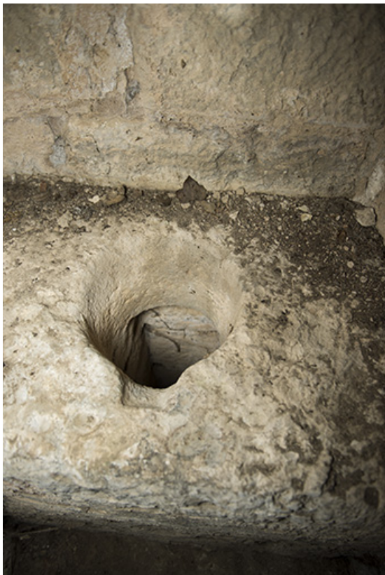
Dans la tour ouest. Détail de latrines.
