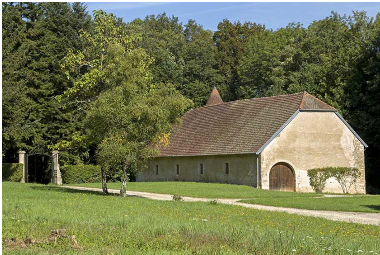
Vue générale du cuvage.
