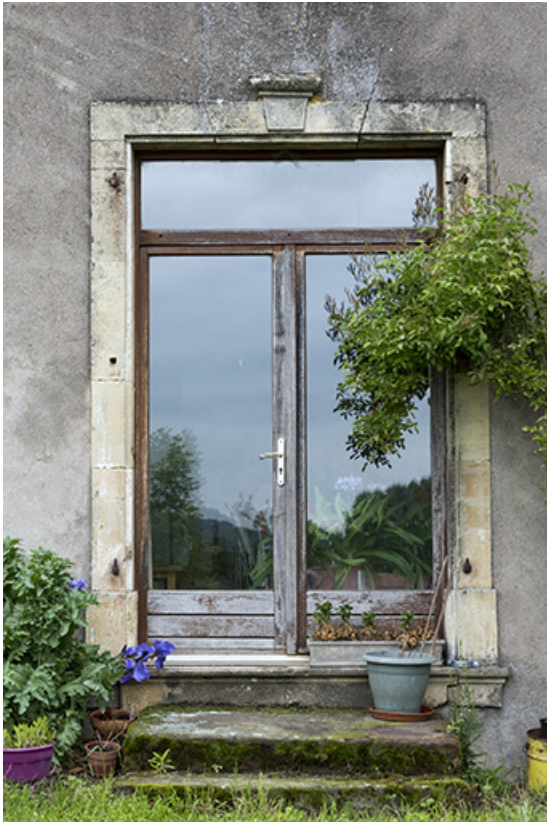
Détail d'une porte, façade postérieure.
