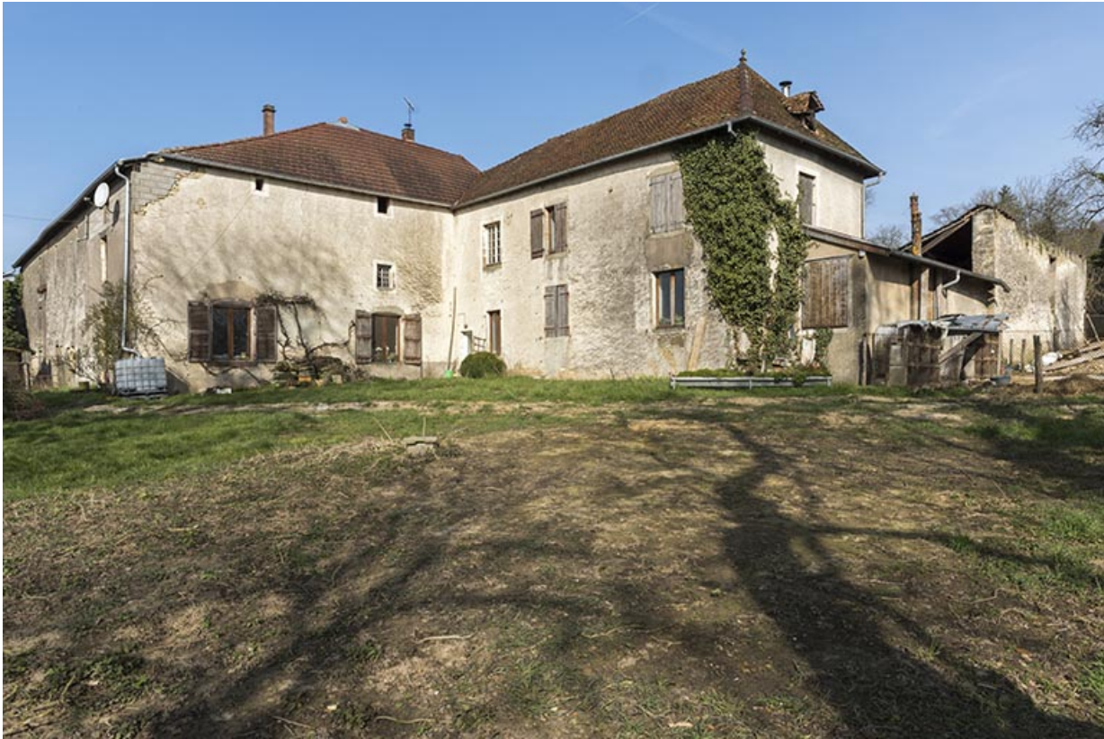
Vue générale, façade postérieure.
