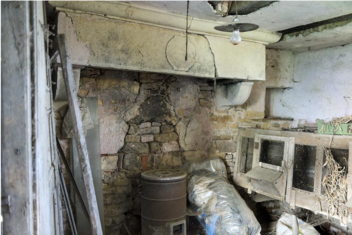
Cheminée au rez-de-chaussée du pigeonnier.
