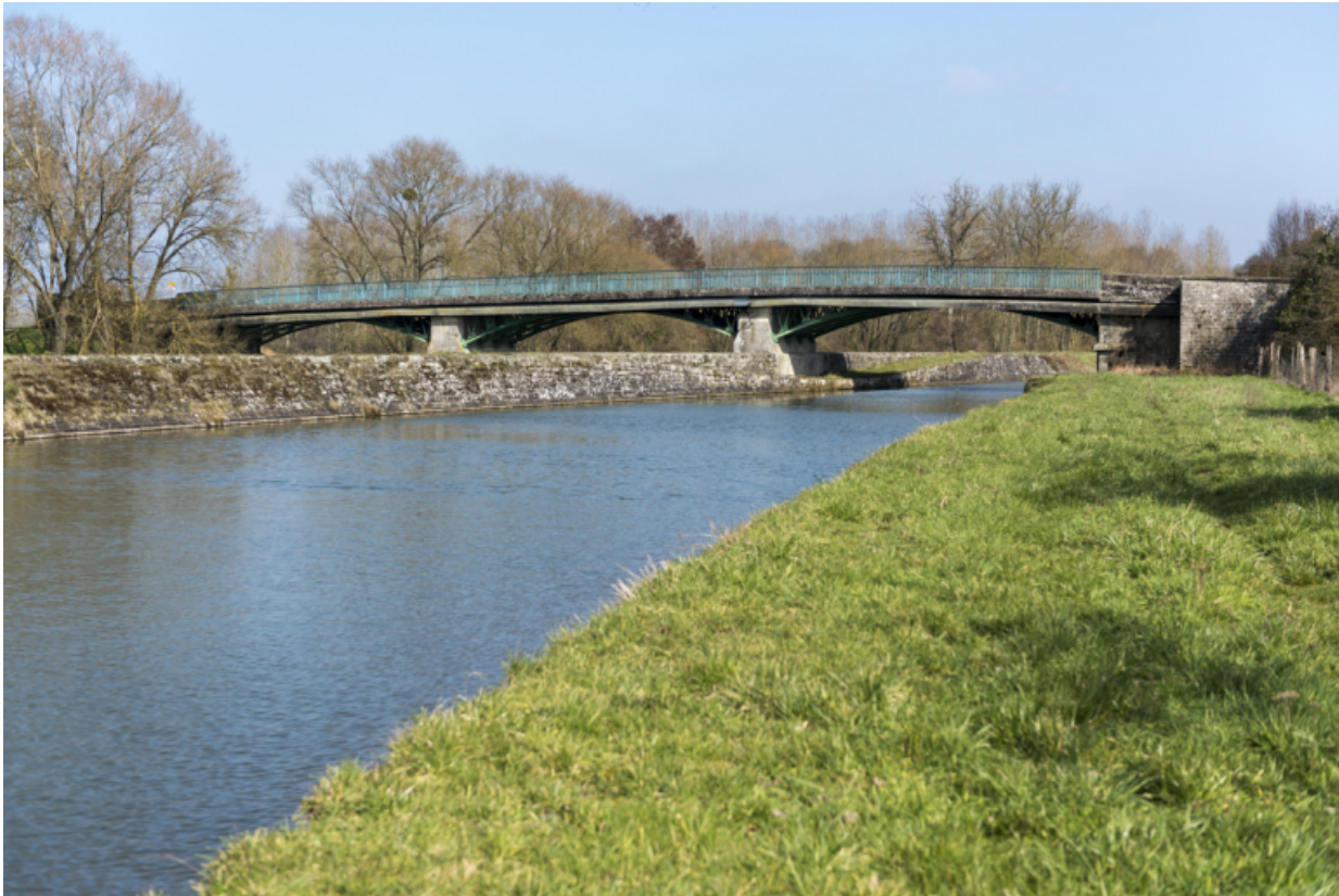
Vue depuis l'aval
