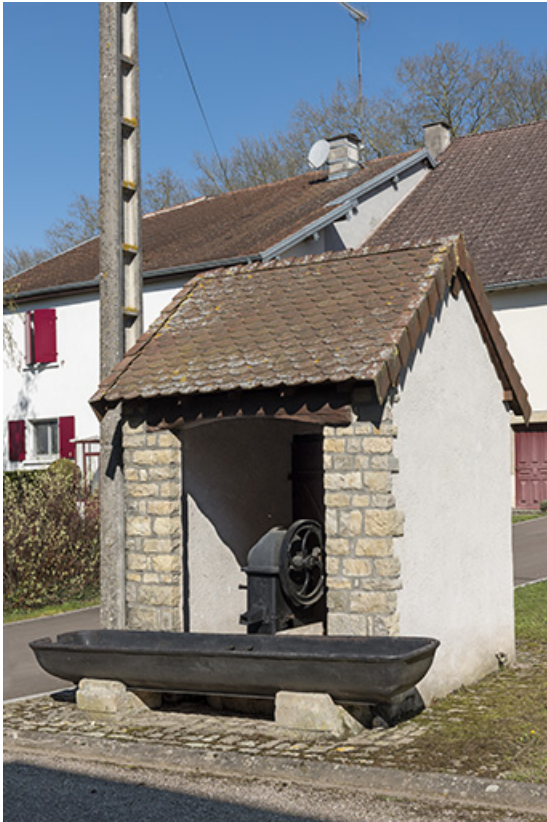
Fontaine à Richecourt.
