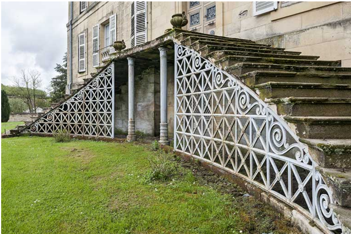
L'escalier double, façade nord.
