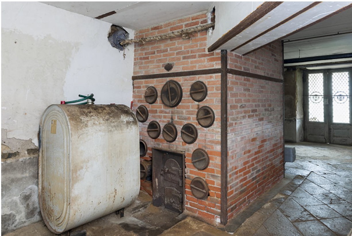
L'ancien chauffage centrale du château.
