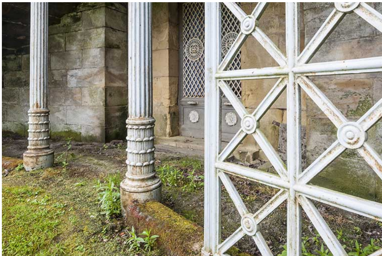
Détail sur l'armature métallique.
