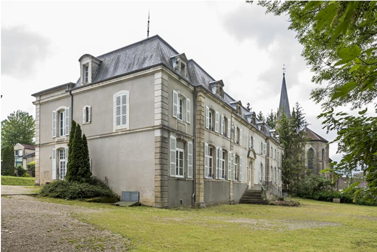
Vue depuis le nord.
