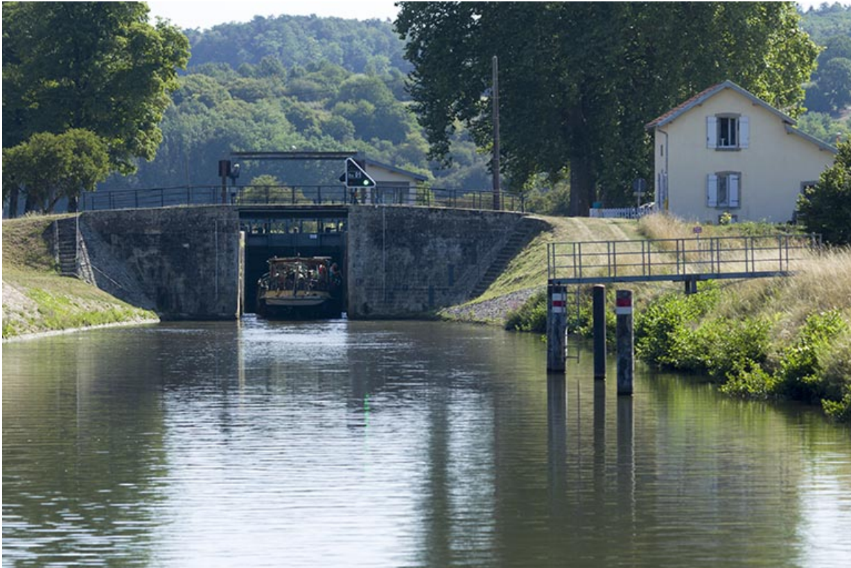
Site d'écluse, Ormoy.
