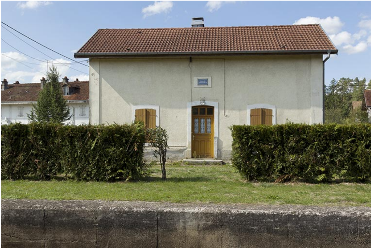
Vue de face de la maison d'éclusier.
