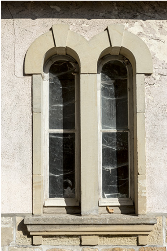
Détail des baies jumelées de l'ancienne dépendance.
