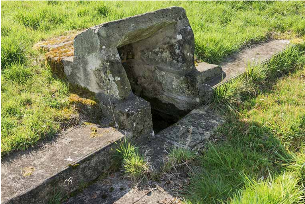
Fontaine d'alimentation du bassin.
