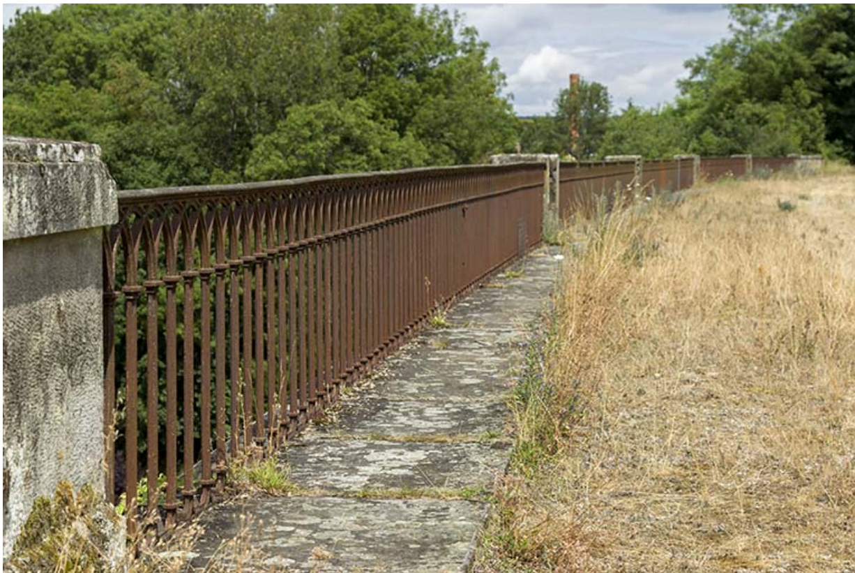
Les garde-corps en fonte.
