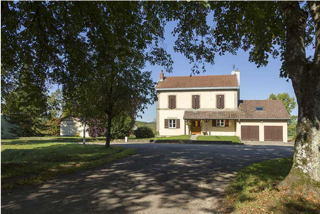
Façade sud-est de l'ancienne gare.
