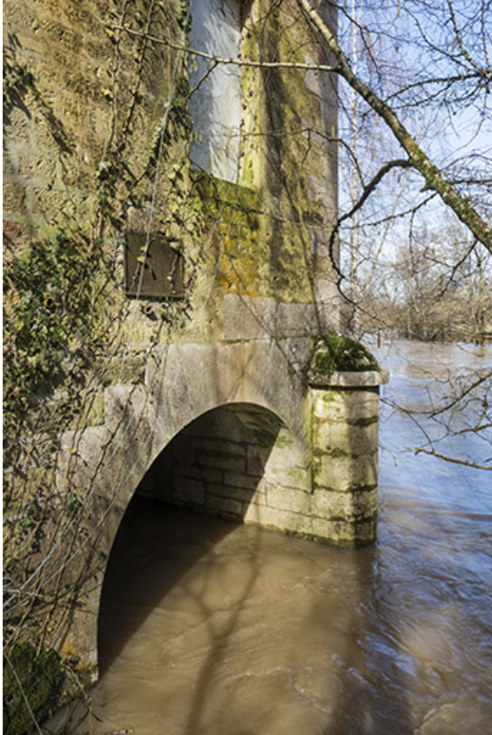
Canal de fuite du moulin.
