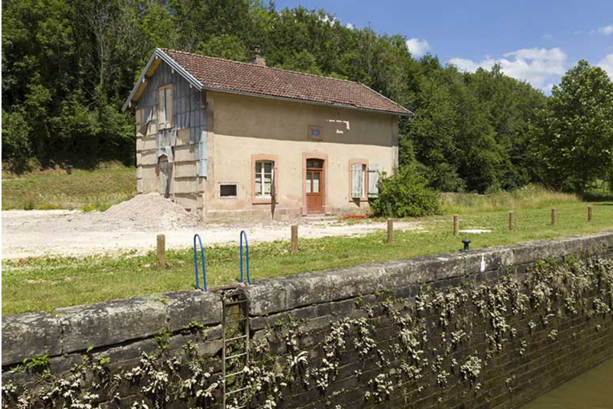
La maison d'éclusier, depuis l'écluse.
