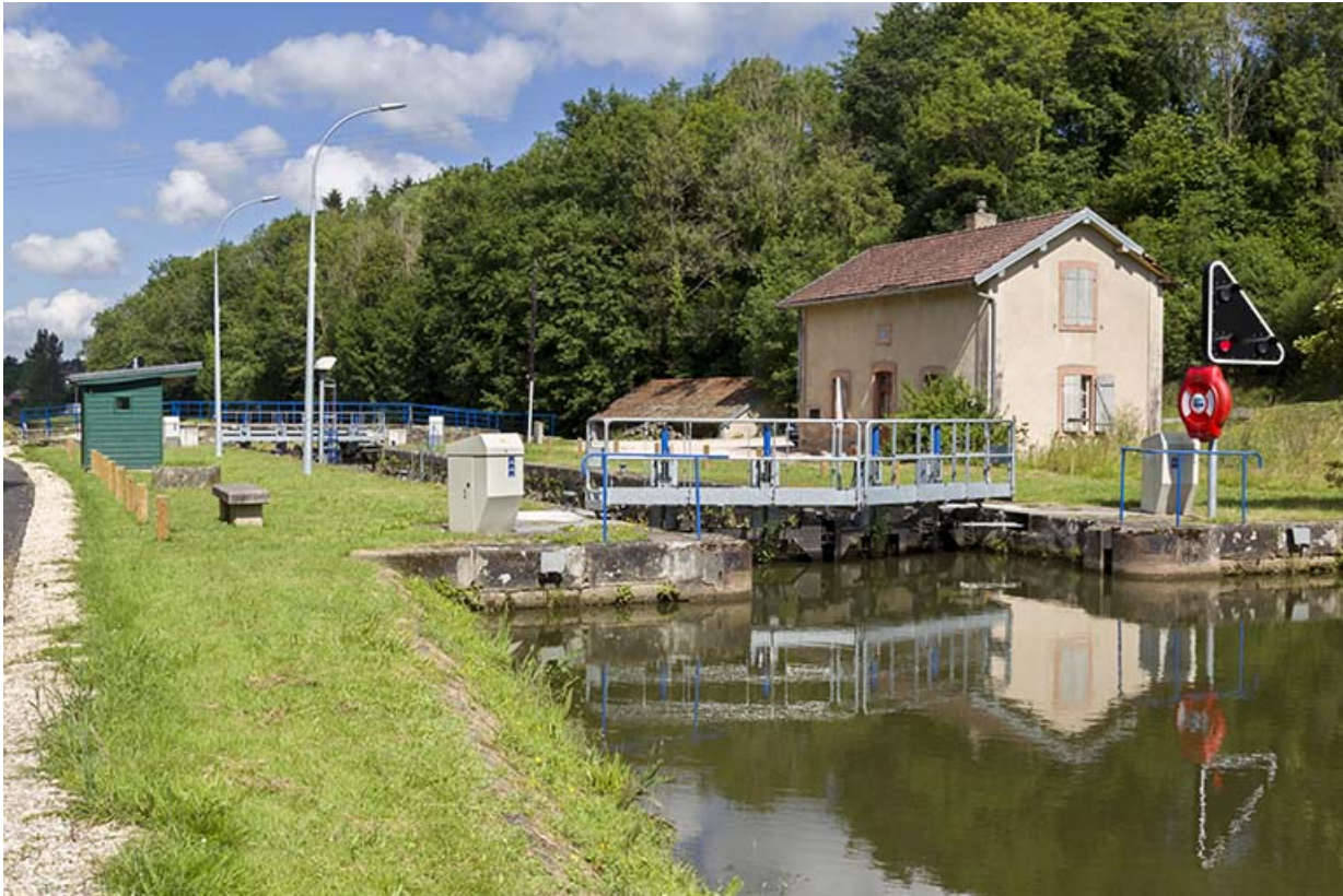
Le site d'écluse, depuis l'amont.
