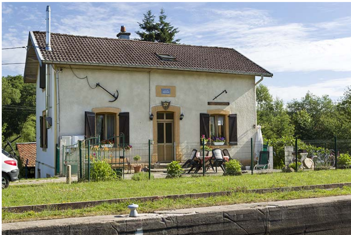
La maison d'éclusier, depuis l'écluse.
