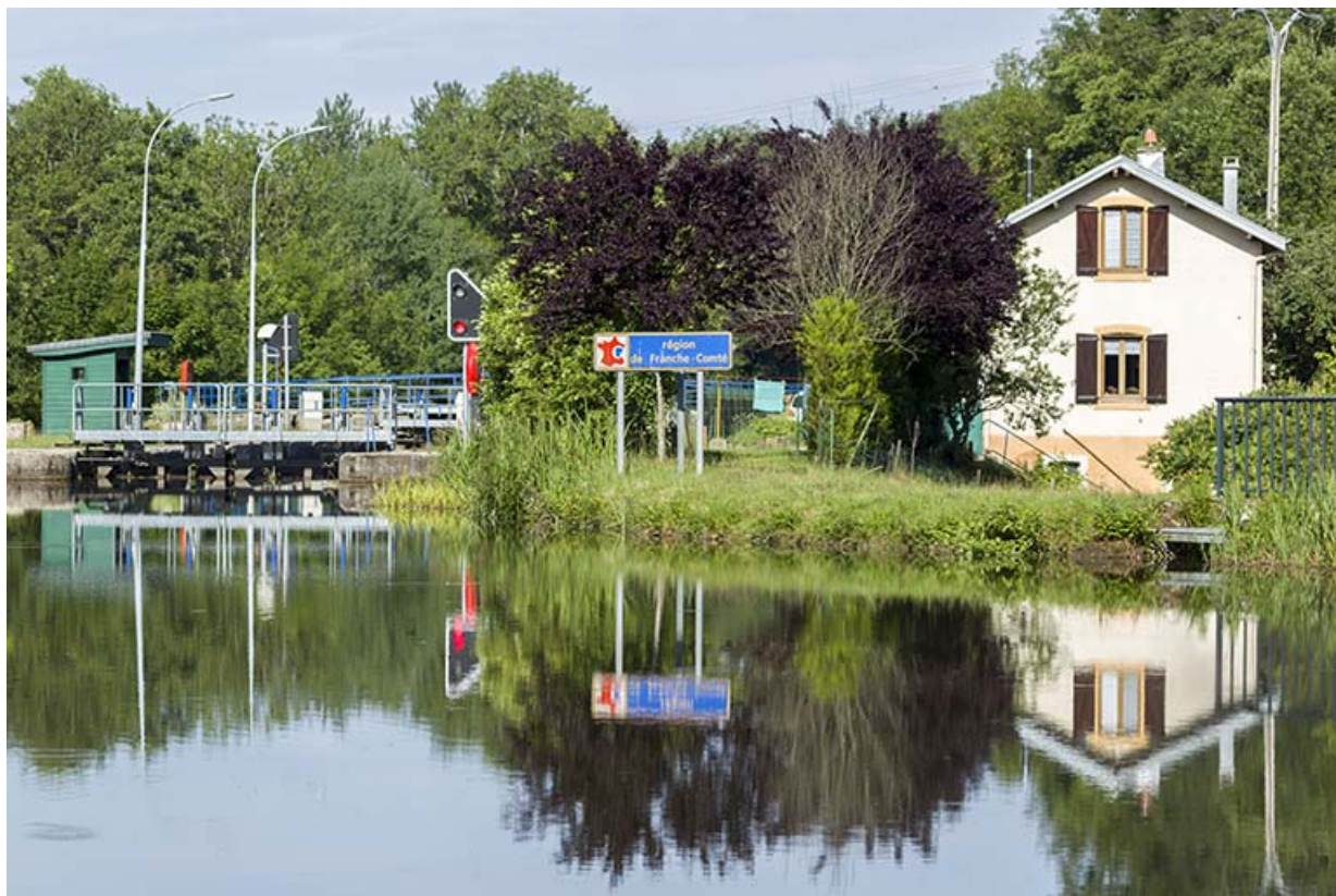
Vue d'ensemble depuis l'amont.
