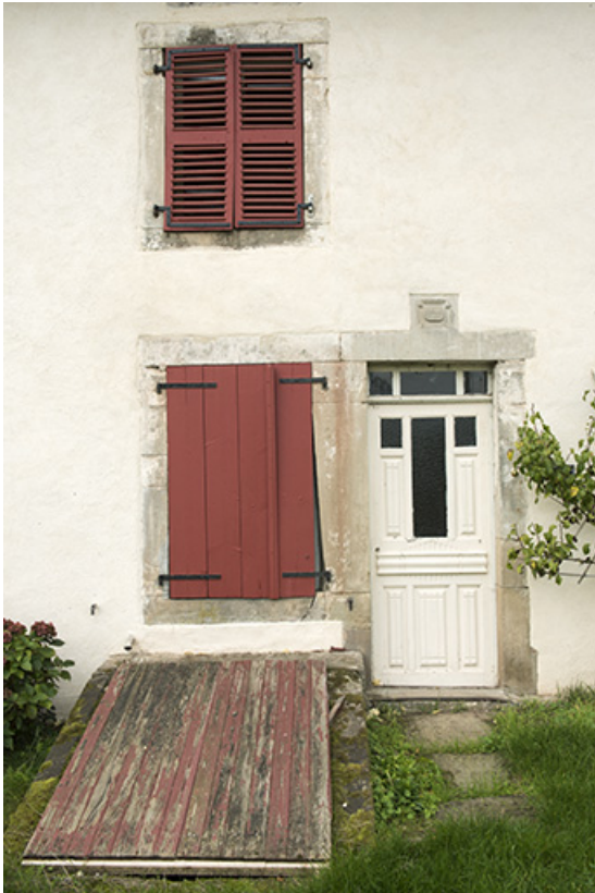
Maison disposant d'un sous-sol.
