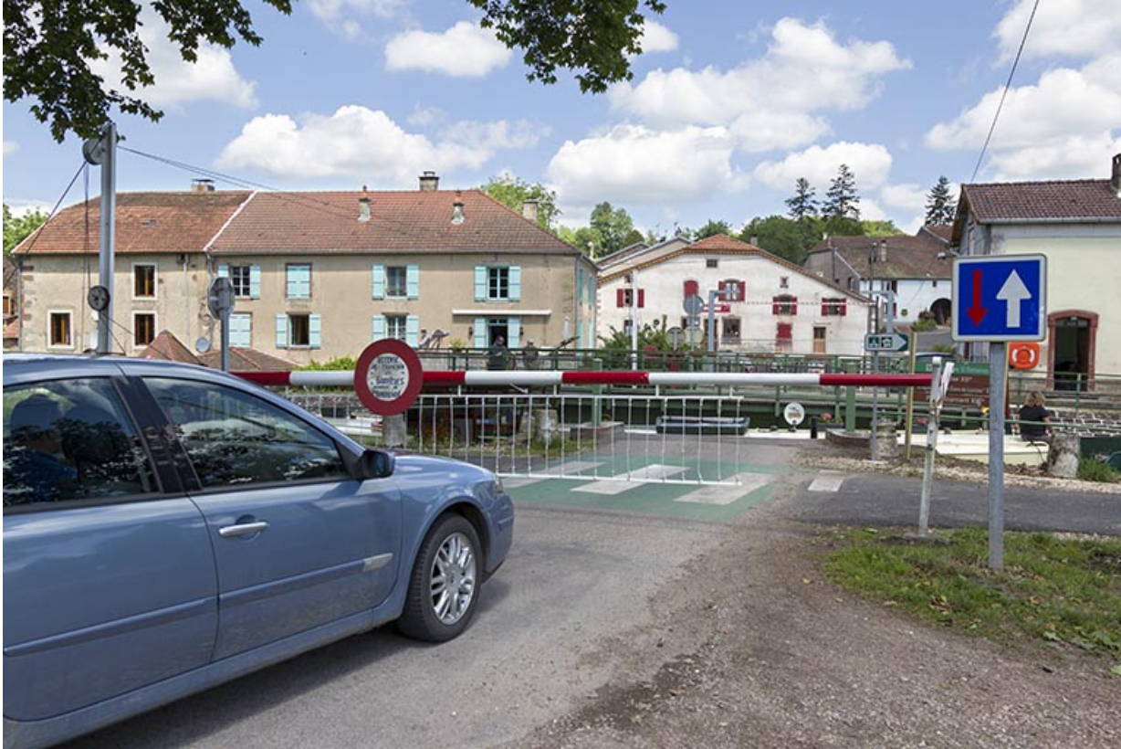
Fermeture du pont à la circulation routière.
