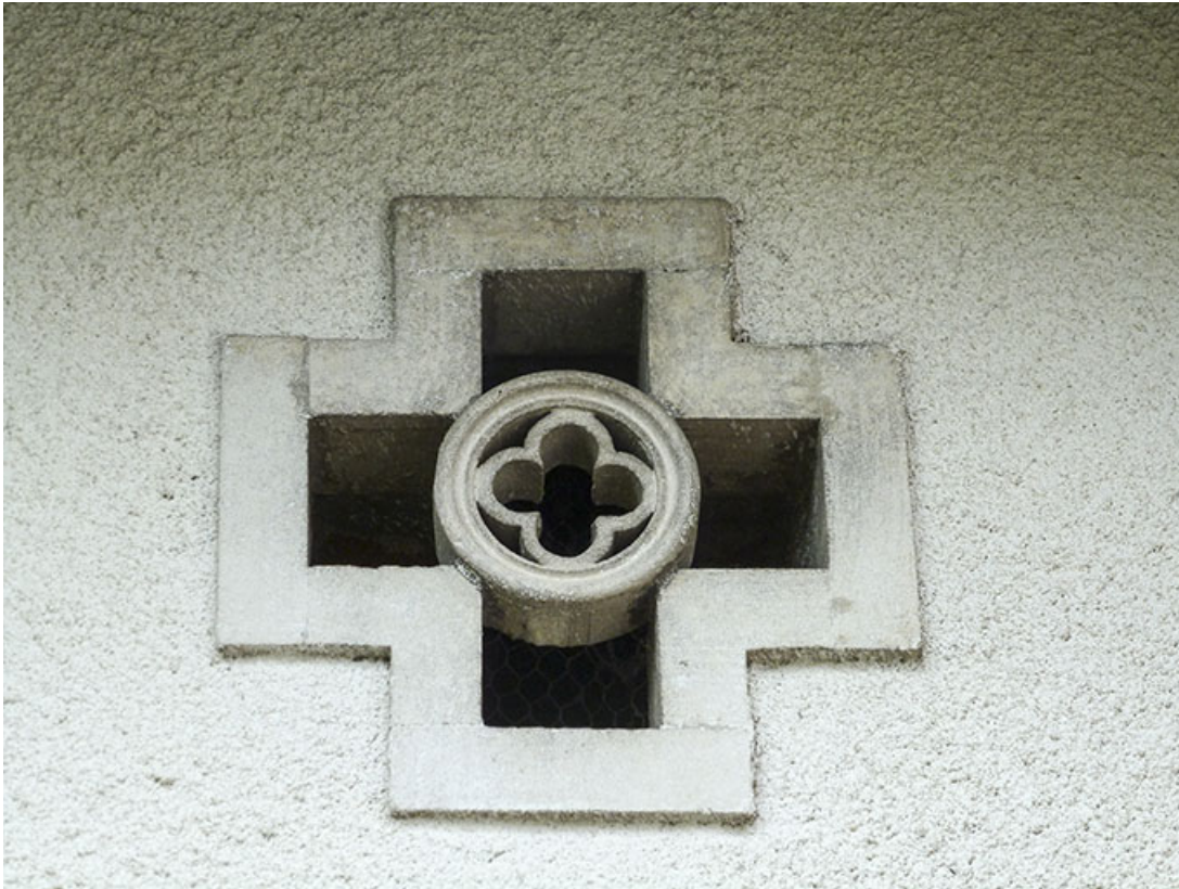
Remise : baie cruciforme de l'étage de comble.
