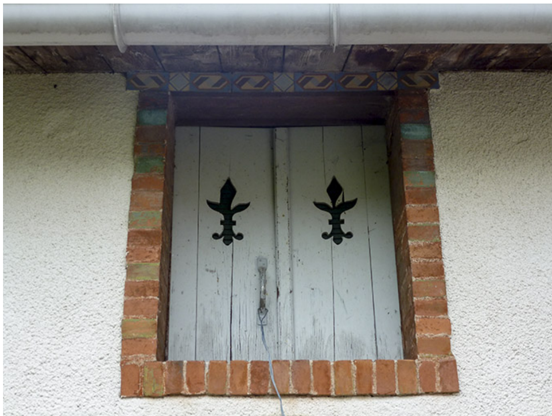
Remise : baie de l'étage de comble.
