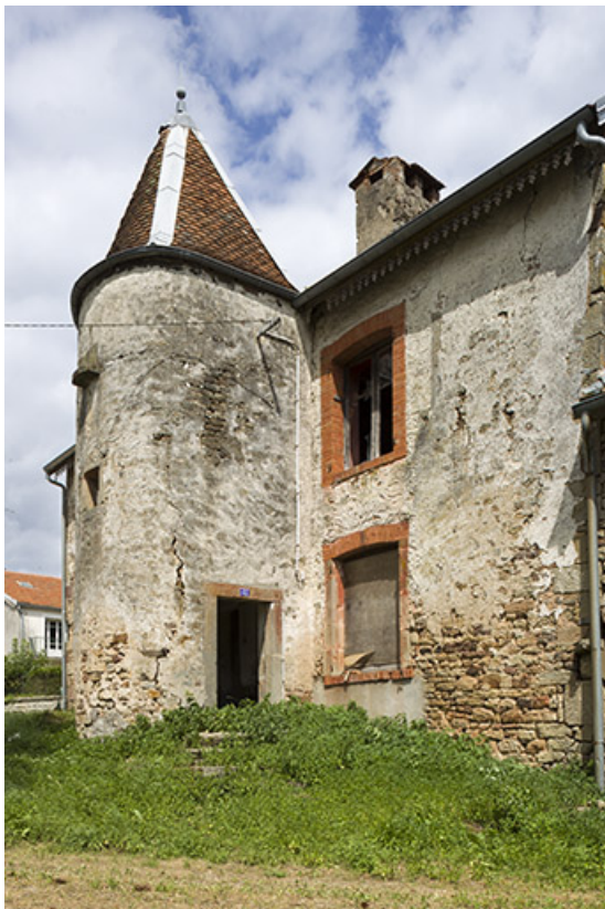
Vue sur la tourelle d'escalier.
