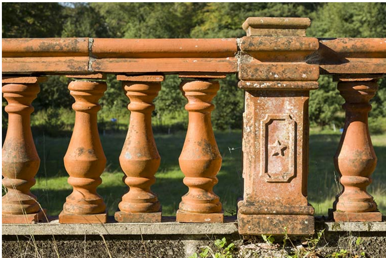
Balustrade de la terrasse, façade nord.
