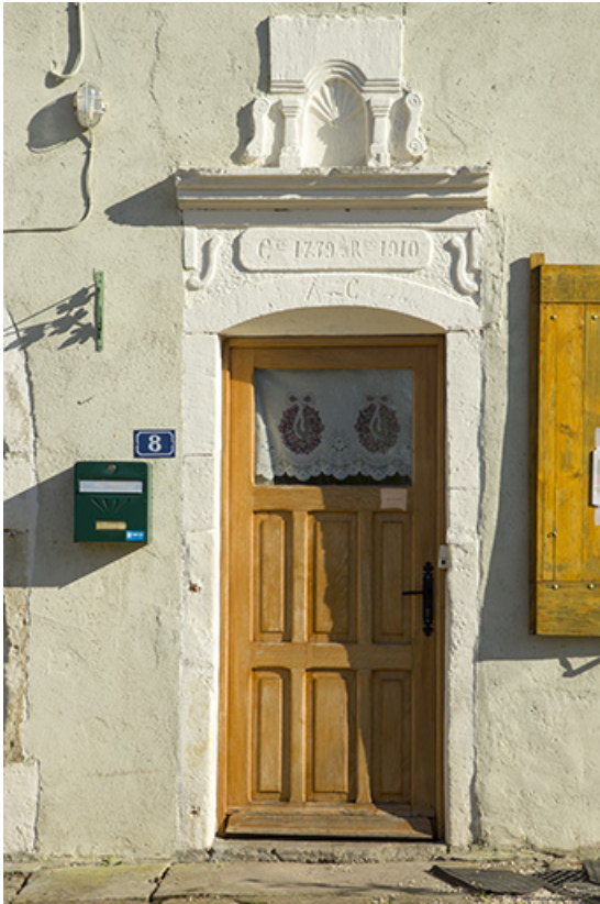
Détail d'une porte, rue Royale.
