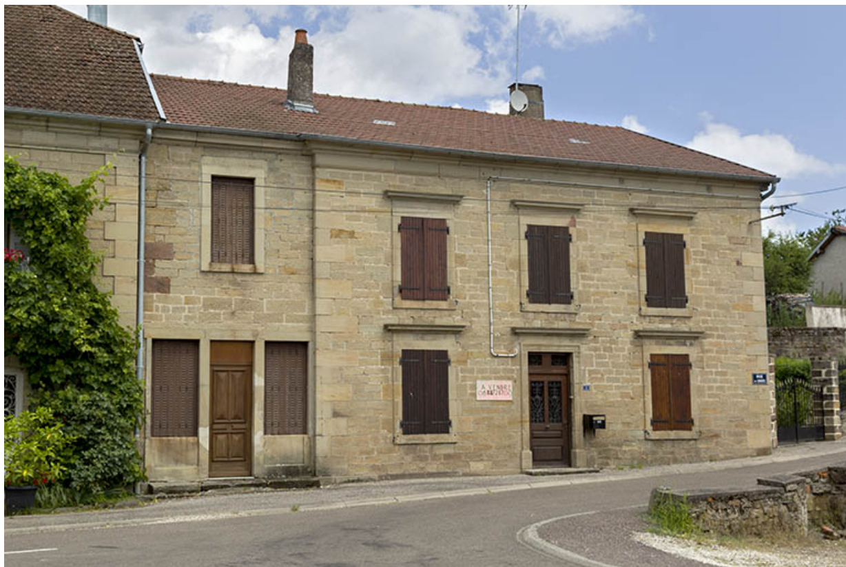
Maison, rue Couelle.
